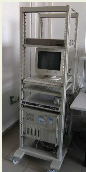
Serwer wideo wraz z modulem CMTS.
