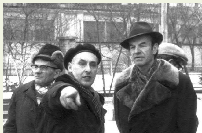
Inżynier Aleksander Korol (w środku), pierwszy Zastępca Dyrektora Instytutu Radioelektroniki ds. Technicznych, na placu budowy Zakładu Opracowań i Wdrożeń Aparatury Radioelektronicznej ZDAR (1973).
