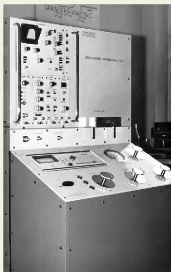
Spektrometr promieniowania alfa - konstrukcja ZEJ, wdrożona w Zakładzie Doświadczalnym ZDAR.
