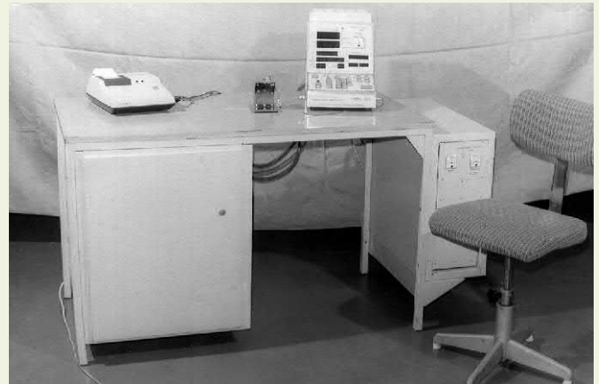
System do pomiarów rezonatorów kwarcowych FRMS-125 - 1983 r. (urządzenia pomiarowe i sterujące zostały ukryte w biurku widocznym na zdjęciu).
