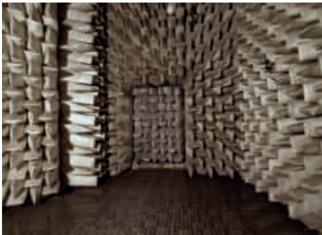
Komora bezechowa Zakładu Elektroakustyki, objętość ok. 250 m 3 , częstotliwość odcięcia ok. 110 Hz, poziom zakłóceń nieprzekraczający 20 dB(A), czas pogłosu poniżej 50 ms.
