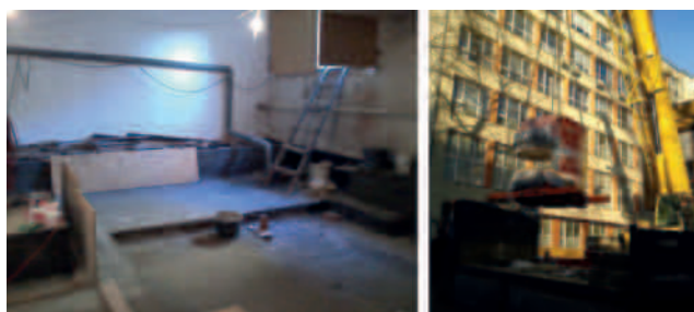
Pomieszczenia WEiTI p.029 przed remontem i transport skanera MRI do pomieszczeń (15.12.2011 r.)
