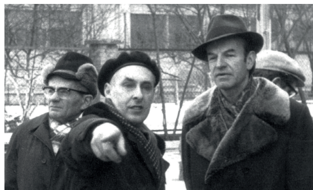
Edmund Porządkowski (piewszy z lewej) i Aleksander Korol (w środku) na budowie ZDAR-u (1974)
