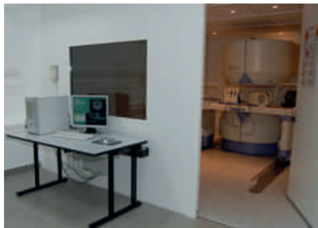
Gotowe pomieszczenia WEiTI p.029 po remoncie (2012) z zainsta-lowanym skanerem niskopolowym
